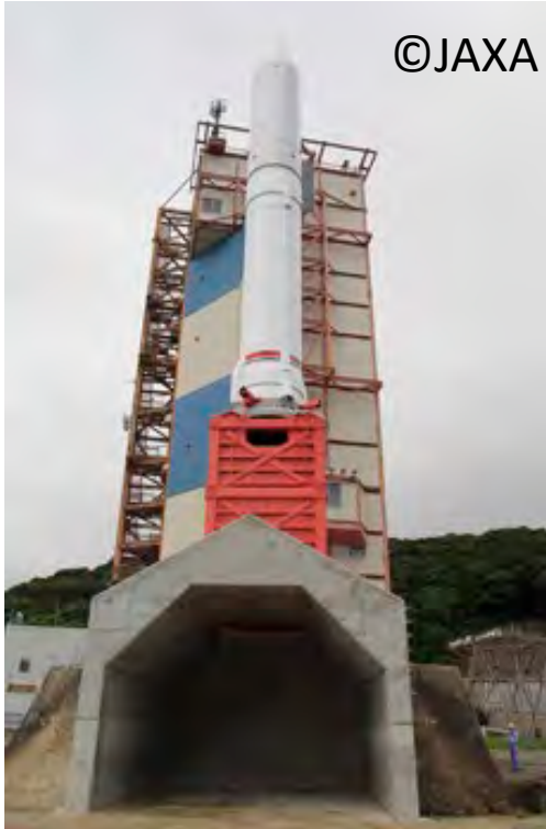
打ち上げ場の煙道
